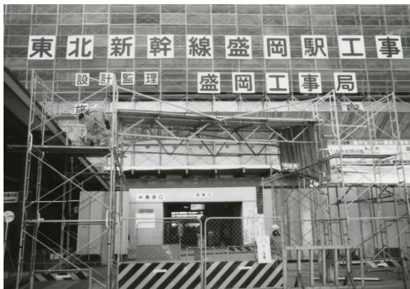
▲ 参考として撮影された工事中の盛岡駅 昭和55年(1980)
